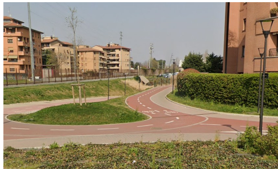
Figura 26 – Esempio di pista ciclabile in sede propria
