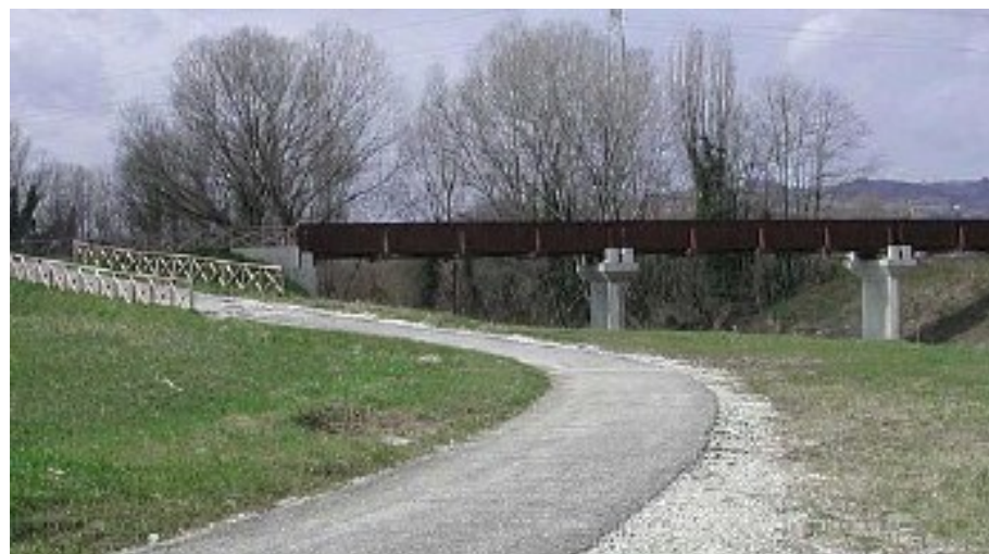
Figura 48 – Piste ciclabili – Pavimentazione in emulsione bituminosa
