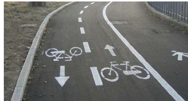
Figura 46 – Piste ciclabili – Segnaletica orizzontale
