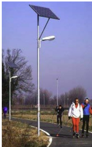
Figura 44 – Piste ciclabili – Esempio di illuminazione con pannelli solari
