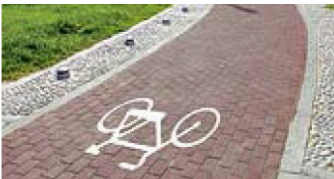
Figura 50 – Piste ciclabili – Pavimentazione in blocchetti di calcestruzzo
