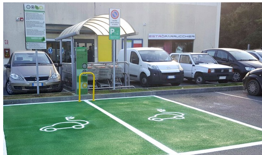
Figura 40 – Esempio di stallone per ricarica di veicoli elettrici
