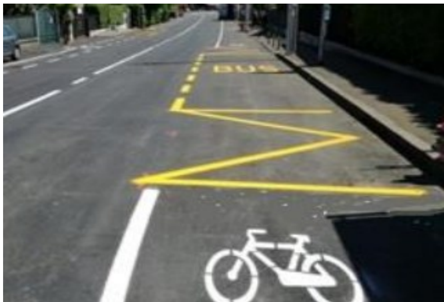
Figura 54 – Corsia ciclabile in corrispondenza di una fermata dell'autobus
