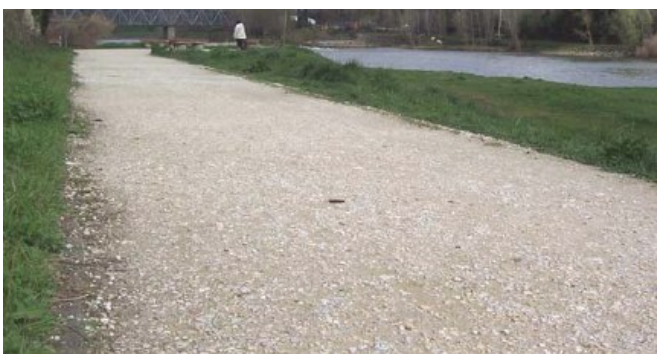
Figura 51 – Piste ciclabili – Pavimentazione in stabilizzato di cava
